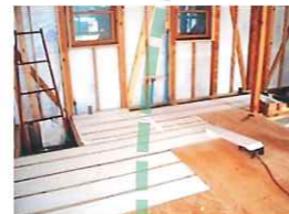
壁・床・天井の断熱改修
