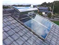
太陽熱温水器設置工事
