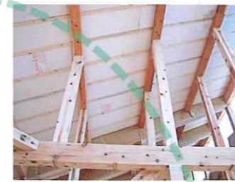
断熱パネルによる省エネ改修 潜熱蓄熱建材による改修 等
