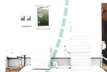
エネファーム等の設備機器設置 地中熱利用の設備設置 等
