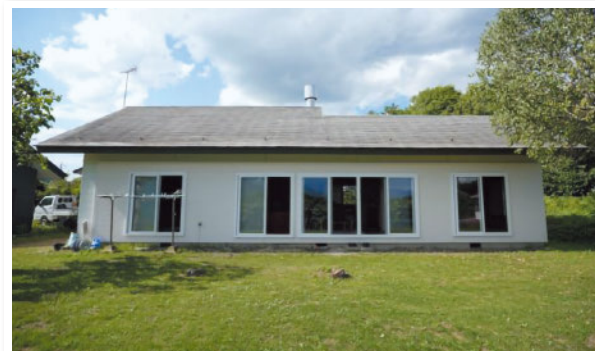
ペアガラスのサッシの入れ替えに合わせ、外壁も工事
