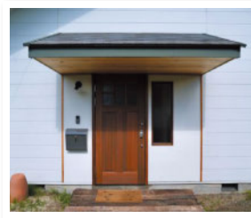
改修後。幅が広く厚みもある木製扉に入れ替え
