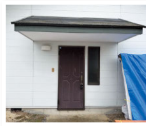
改修前の玄関扉
