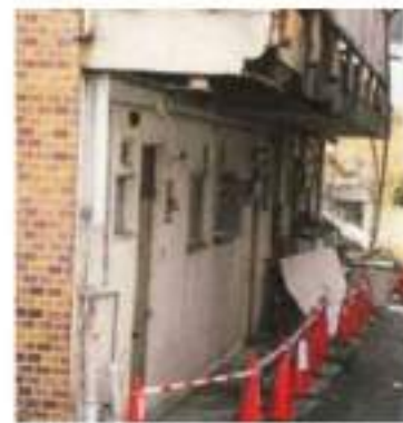
外壁剥落等の危険な状態
