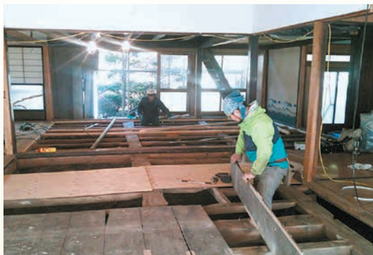
第二弾のメイン作業は「床」。畳を片付け古い床を取り外し、床下地を張るという重労働
