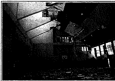
H23.3月 北部地震 体育館の天井落下
