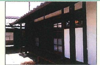
【古民家を宿泊施設に改装】
