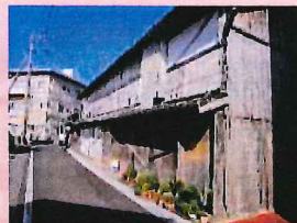
空き家の除却
