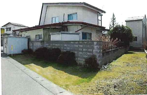
北側全景 ブロック塀手前の土地は、別敷地
